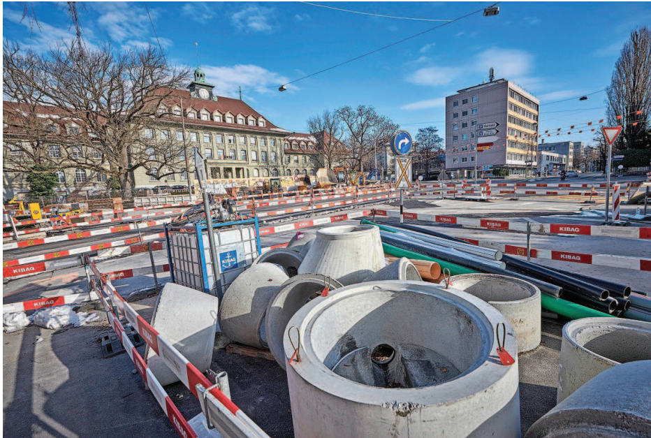
Seit Herbst werden an der Kornhausstrasse und am Viktoriaplatz Werkleitungen saniert. Ab kommenden Montag starten die Arbeiten auch an der Moserstrasse, die Richtung Breitenrainplatz führt. Foto: Adrian Moser
