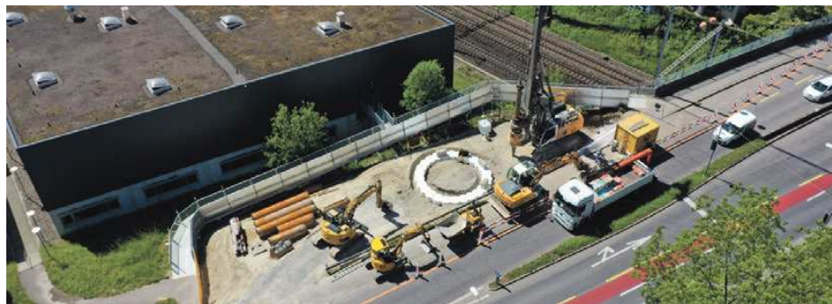
Die Arbeiten für die Erneuerung der Trinkwasserleitungen sind seit März im Gang: Bau der Zielgrube bei der SBB-Brücke
